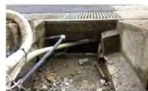
図-16 側溝活用写真 (撮影：みち研)
