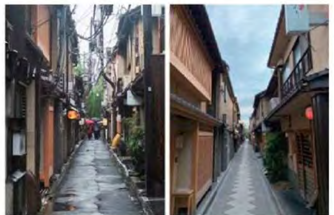
工事前 電柱抜柱後
