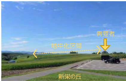
写真-1 新栄の丘展望台付近の地中化（美瑛町）。ビューポイントから近傍町道の電線電柱類を見えなくするため地中化を実施
