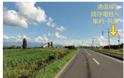
写真-6 地域を象徴するシンボルツリーの眺め（左）を阻害しないよう、通信線を右側の電柱に移設・共架した（美瑛町）
