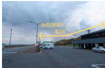
写真-2 「道の駅」前面道路の無電柱化（小平町）。施設裏側に電線電柱を配線し、施設への眺望や施設前の日本海の眺望を向上させた
