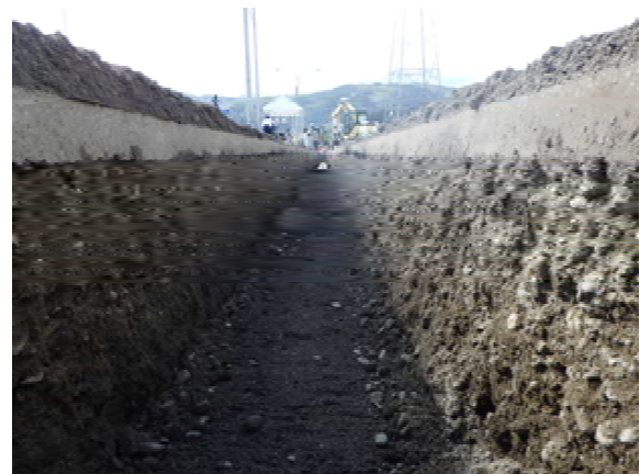
写真-2 掘削後の仕上り
