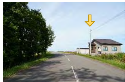
写真-7 無電柱化済みエリア周辺で新たに住宅と電柱が建てられた事例
