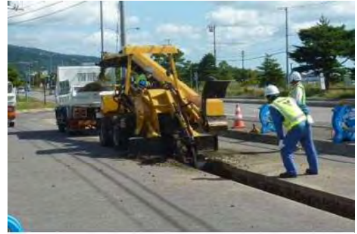
写真-2 トレンチャー掘削状況
