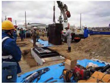
事前検証の全景(延長約10m)
