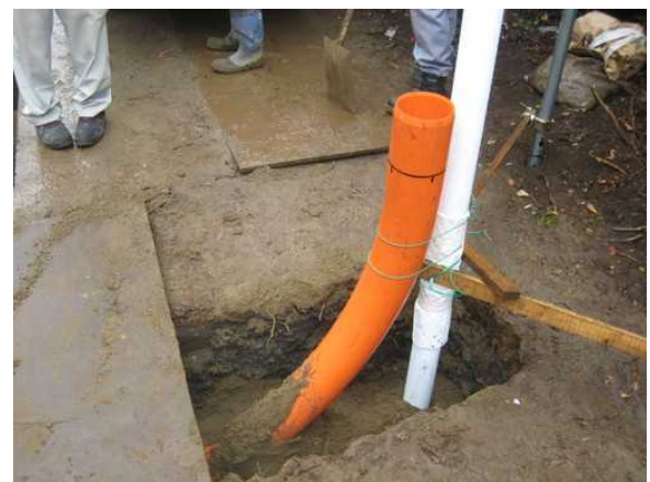
引込み管の立ち上げ状況
