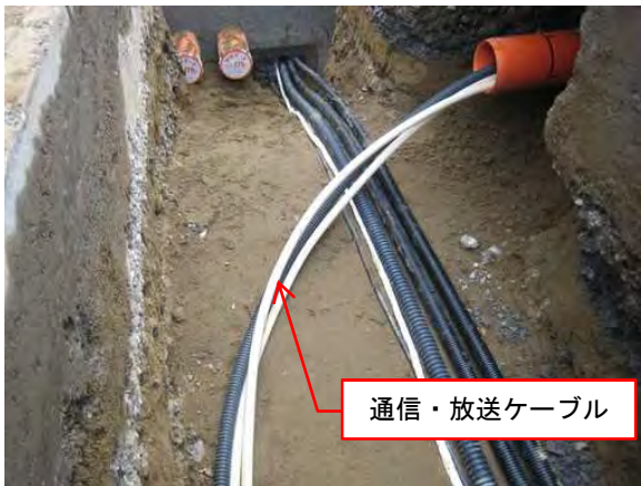
通信・放送ケーブルの引込状況
