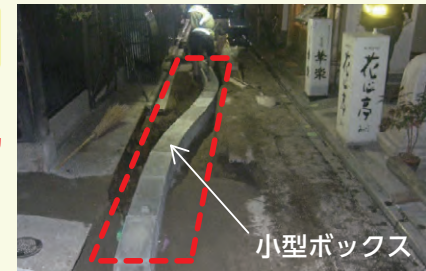
整備中の状況
