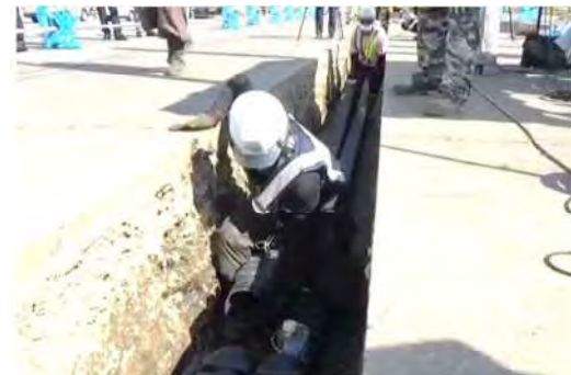
写真-3 角型多条電線管の敷設状況
