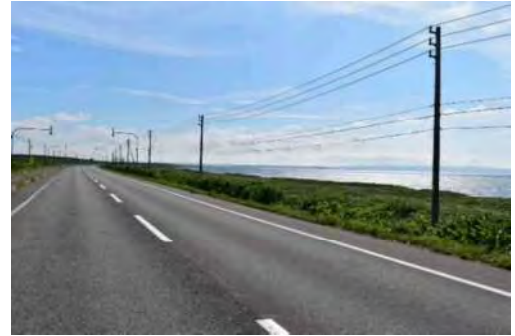
写真-1 地中化ニーズの高い郊外部の道路
