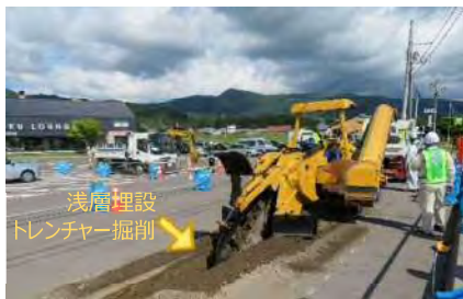
写真-4 「道の駅」前面の国道で行われた電線共同溝事業（七飯町）。寒冷地における浅層埋設やトレンチャー掘削を実施した
