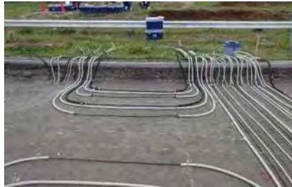
ケーブルを舗装に埋設
